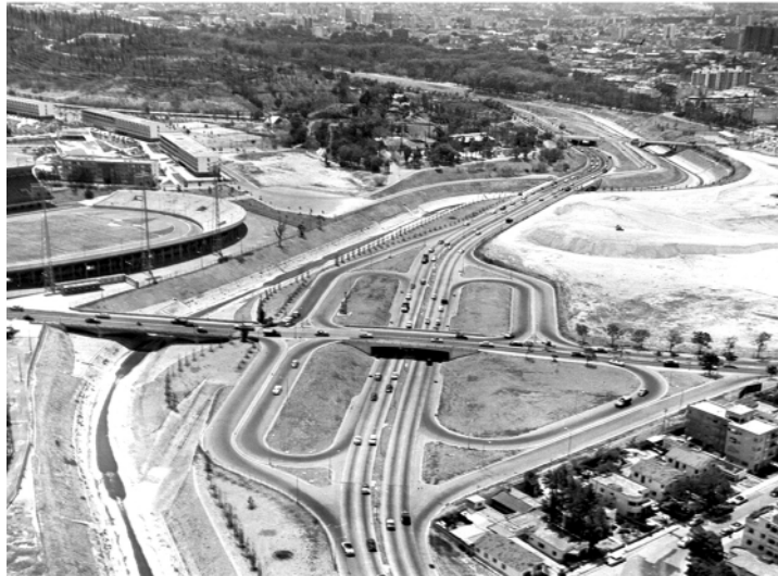
Imagen 2: Autopista del Este. Distribuidor Plaza Venezuela
